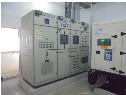
รูปที่ 35 ตู้ควบคุมไฟฟ้า
