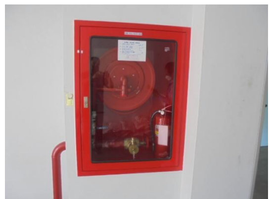
รูปที่ 30 ตู้เก็บสายดับเพลิง
