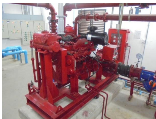
รูปที่ 50 เครื่องสูบน้ำดับเพลิงของโครงการ
