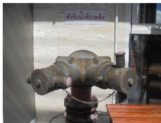
รูปที่ 46 ท่อรับน้ำของโครงการ
